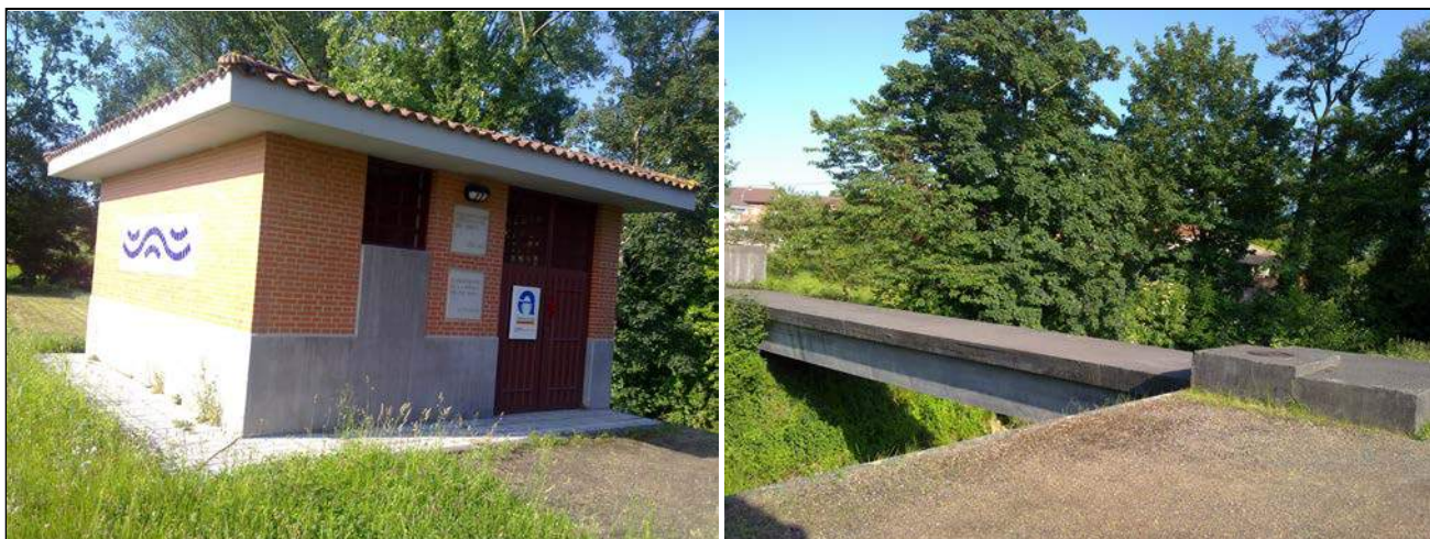
Izq.: Aliviadero de Saneamiento Nora-Noreña, inaugurado en 1997. Der.: Pasarela Municipal junto al Aliviadero de Saneamiento.
